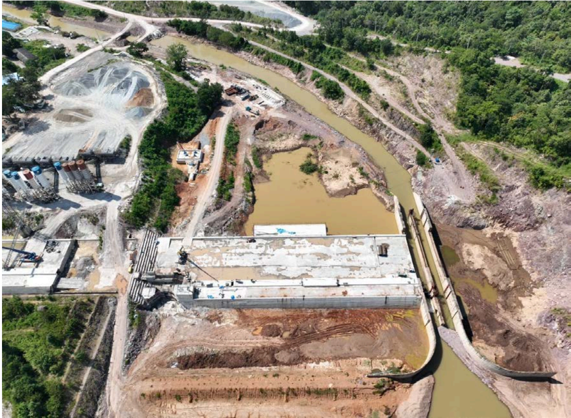
รูปที่ 1.9-2 ความก้าวหน้าการก่อสร้างอาคารระบายน้ำล้น
